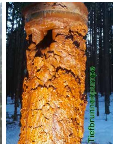
Nachdem der Tiefbrunnen 1 regeneriert und damit die Wasserversorgung wieder gesichert war, wurde auch die Pumpe vom Tiefbrunnen 2 durch eine energiesparende Pumpe ersetzt und gleichzeitig die
